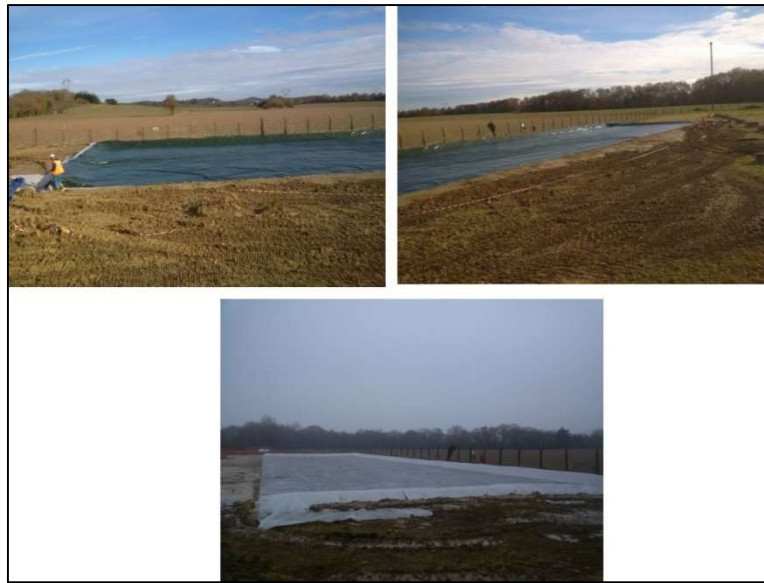
Figure 6 : Aire de stockage des matériaux pollués
