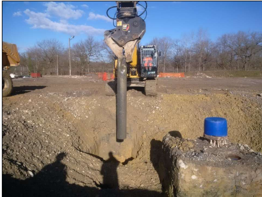
Figure 9 : Retrait d'un tubing enterré à proximité de la tête de puits
