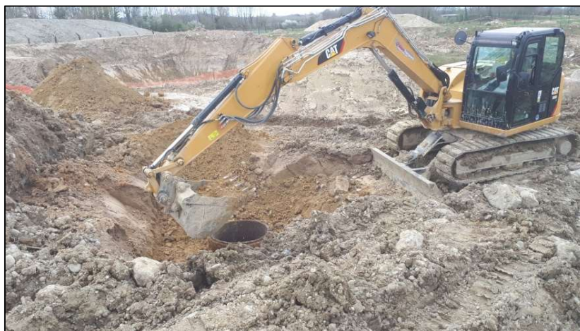
Figure 10 : Opération de retrait d'un puisard
