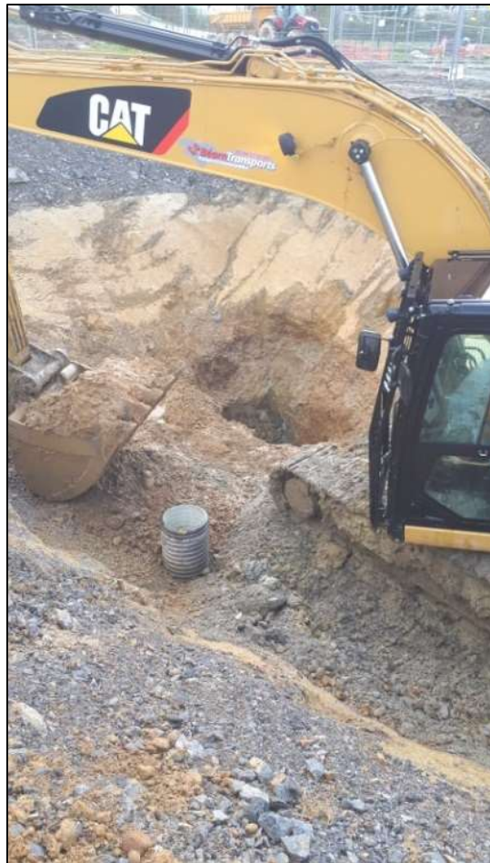
Figure 15 : Photographie d'un terrassement d'une zone polluée (zone « Tête de puits »)
