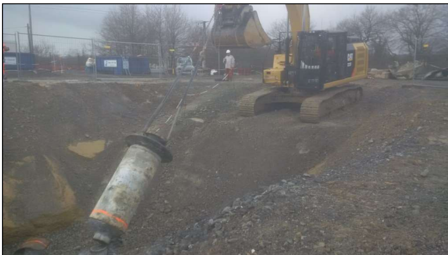
Figure 8 : Retrait de la tête de puits
