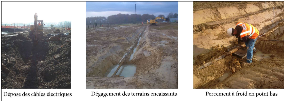
Figure 12 : Opérations de retrait des réseaux et câbles électriques
