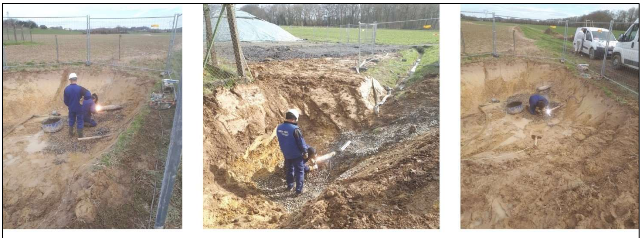
Figure 13 : Découpe et soudure des tampons métalliques sur les réseaux intersites.
