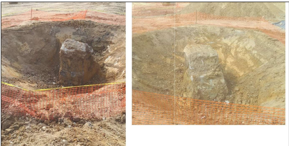
Figure 11 : Découverte de deux massifs bétons
