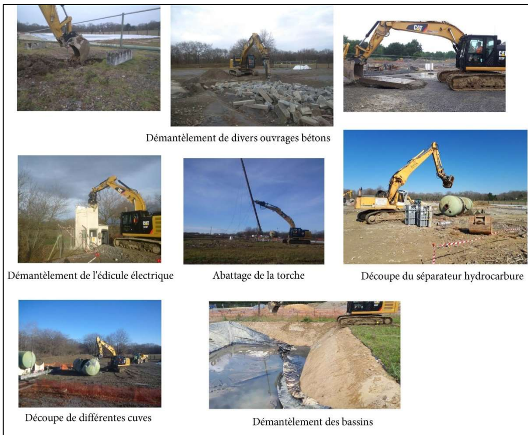
Figure 7 : Reportage photographique illustrant les différentes étapes du démantèlement des installations de surface
